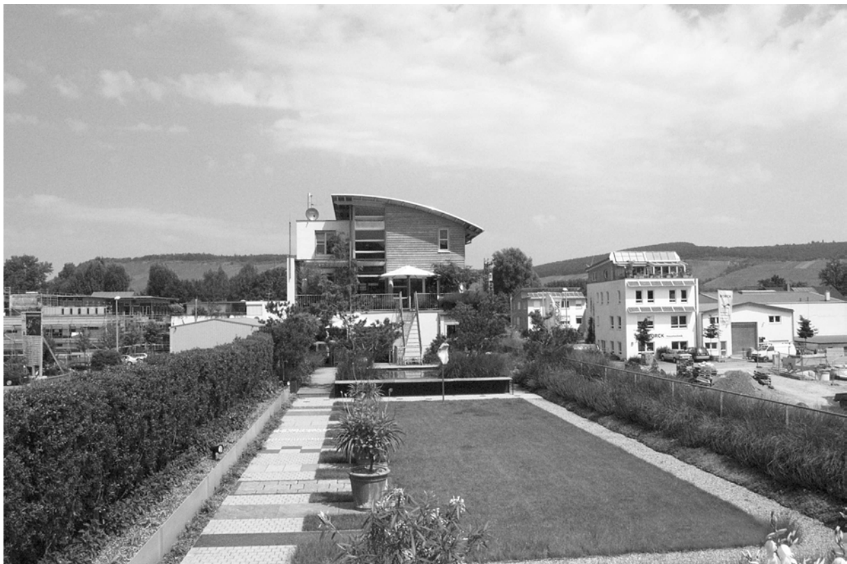
Abb. 4: Dachbegrünungen mit begehbaren Rasenflächen erfordern eine intensive Pflege
