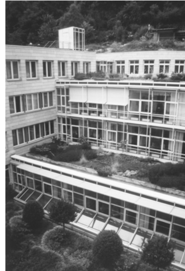
Abb. 3: ... noch intensive Dachbegrünungen
